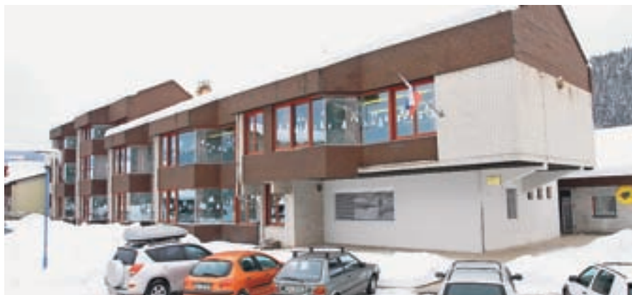
Med prvimi projekti v novem mandatu bo nadgradnja šole, ki je nujna tudi zato, da bodo na občini lahko v sodelovanju s Švicarji uresničili energetski projekt. / Foto: Polona Mlakar Baldasin
