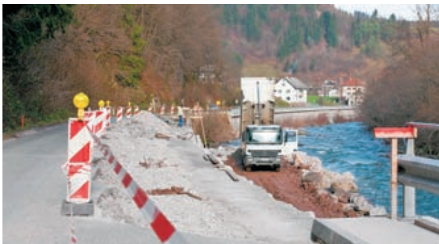
Dela na prvem odseku obnove ceste na Sovodenj so se začela.
