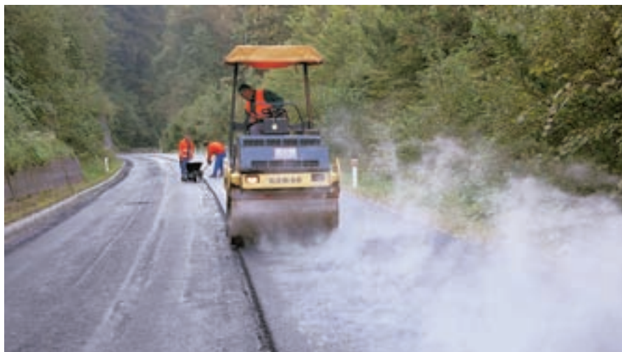
Veliko odsekov regionalnih ceste v občini še ni primerno urejenih. Prejšnji teden so vzdrževalci na novo preplastili odsek na Fužinah.
