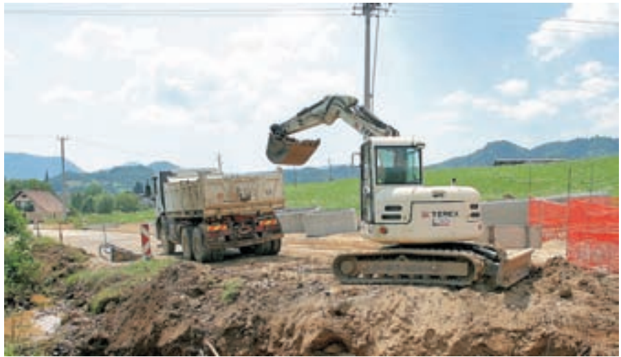
Gradnja panoramske ceste proti Križni gori / Foto: Tina Dokl
