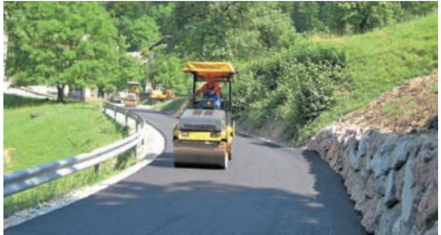
Cesto v Lajšah so razširili in preplastili.
