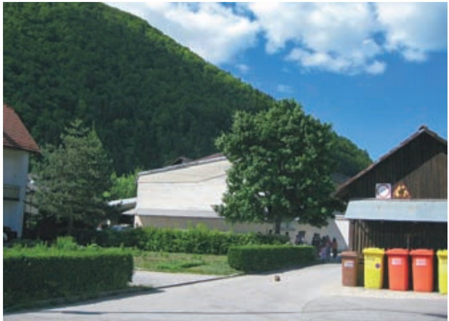
Parkirišča bodo zgradili na mestu sedanjih vrtov pred šolskim blokom.
