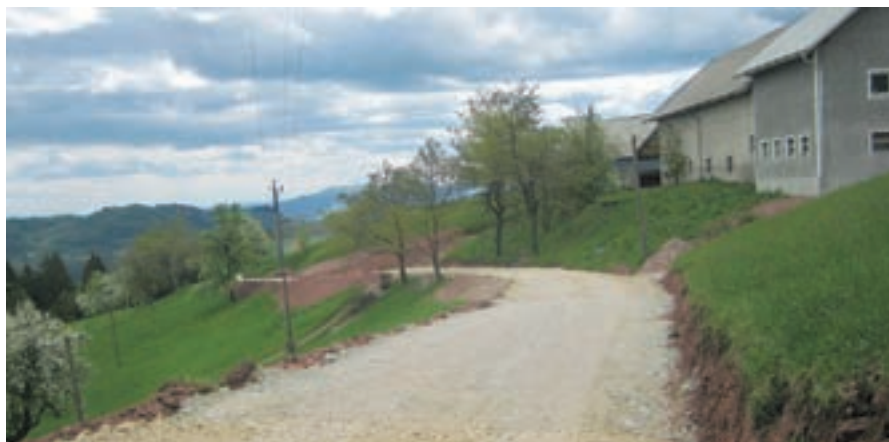
Panoramska cesta v Žirovskem vrhu je skoraj v celoti pripravljena na asfaltiranje. To bo opravljeno do občinskega praznika.
