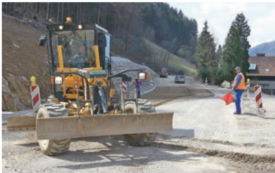
V teh dneh polagajo asfalt na cesti Puštal-Draga.
