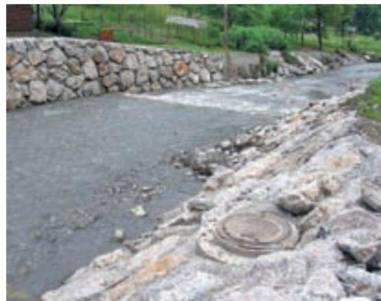
... in po sanaciji.
