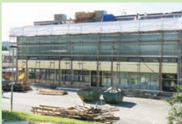
S popravilom strehe na OŠ Ivana Groharja bo objekt tudi energetsko varčnejši.
