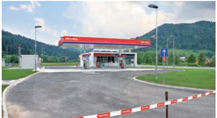
Bencinski servis naj bi tri mesece po izgradnji le začel delovati, dosedanega pa bodo kmalu zatem podri.
