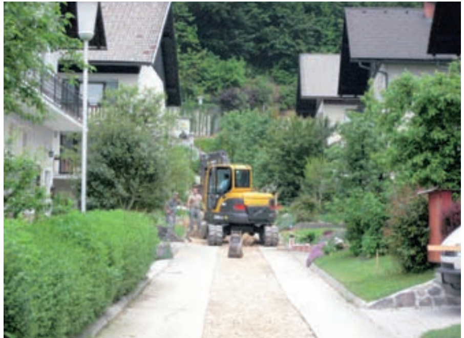
Gradnja kanalizacije v strnjem naselju nasproti pokopališča v Selcih
