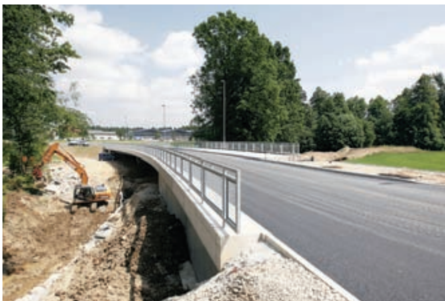
V industrijski coni so dokončali gradnjo mostu čez potok Žabnica in asfaltirali dovodne ceste.
