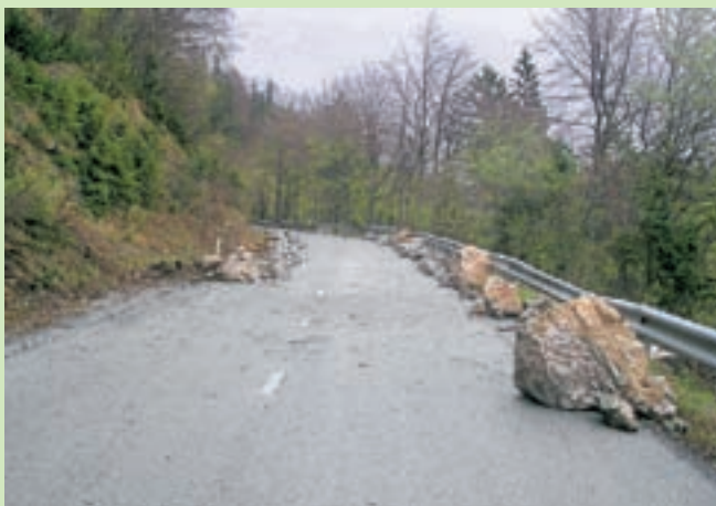
Cestno podjetje Kranj je skale že odstranilo s ceste, v nadaljevanju pa bodo sanirali brežino nad njo.
