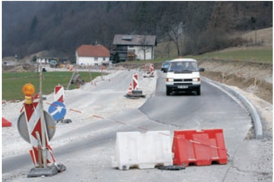
Nadaljujejo z gradnjo odseka Podlubnik-Klančar. / Foto: Gorazd Kavčič
