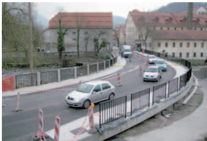
Končali so z obnovo Šeširjevega mostu.
