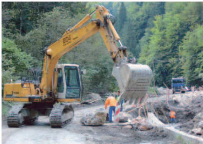
Rekonstrukcija spodnjega dela ceste v Davčo. Načrti za novo davško cesto naj bi bili narejeni do konca leta.
