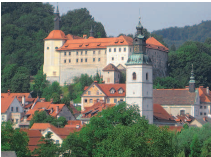
Pogled na Škofjeloški grad je po (delni) obnovi pročelja še bolj veličasten.
