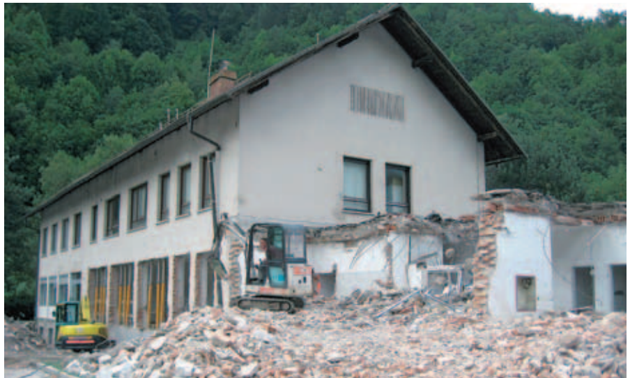
Zdravstveni dom na Racovniku je v teh dneh že pravo gradbišče.
