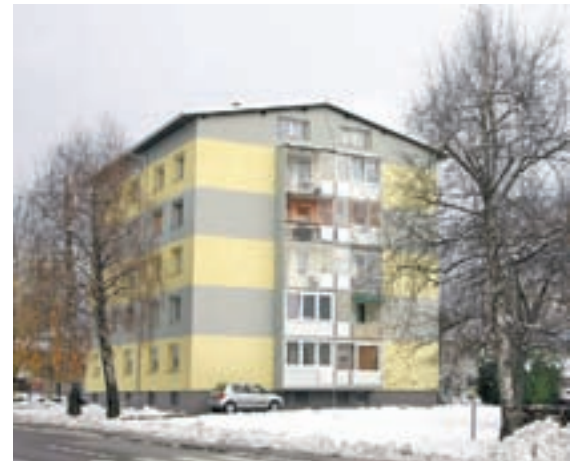
K zmanjševanju porabe energije vplivajo tudi prenove in izolacije fasad starejših stavb. Pred dnevi so zaključili dela na objektu Zoisova 4 v Kranju.
