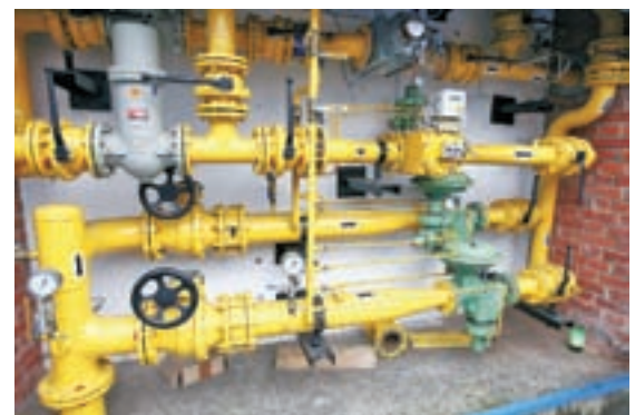
Danes kotlovnica Planina po 7 kilometrov dolgem razvodnem omrežju in 66 toplotnih postaj zagotavlja toplotno oskrbo več kot 4.300 odjemalcem.
