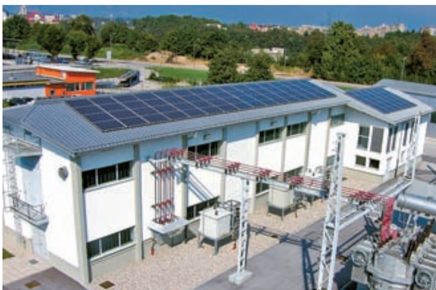
Sončna elektrarna Labore 2
