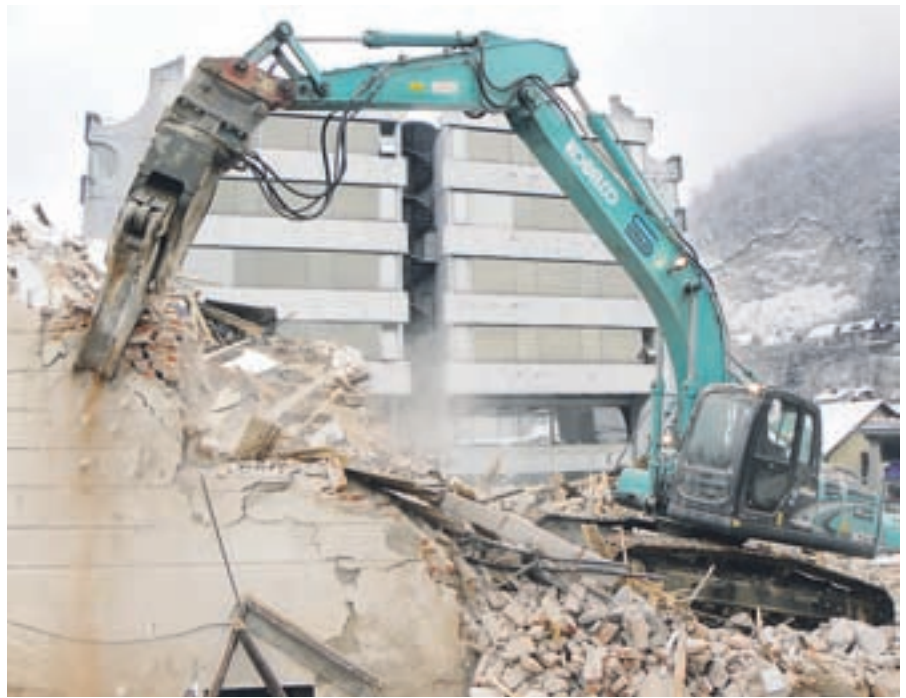
Rušenje upravne stavbe Peka v Trziču
