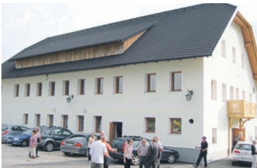
V Sorci so obnovili zadržni dom.
