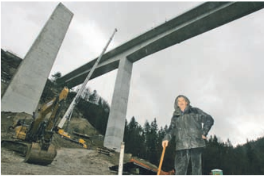
Radovljčan Lado Eržen je zaprl pot do gradbišča novega viadukta Peračica.
