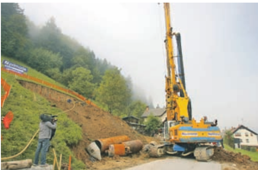
Začetek gradnje poljanske obvoznice
