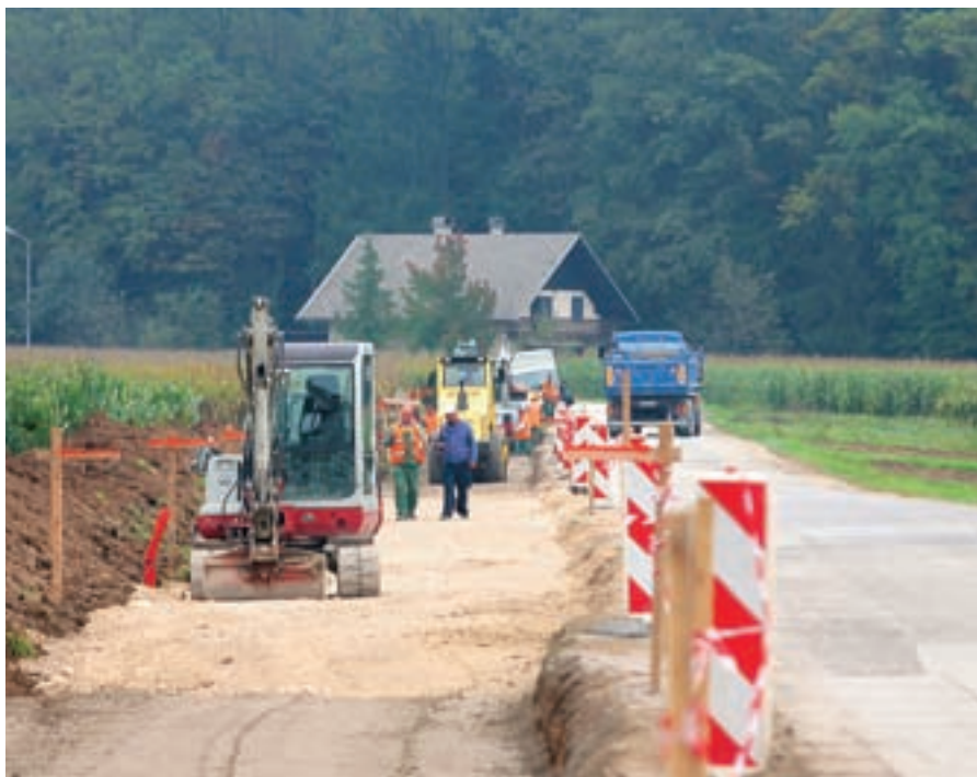
Cesta iz Voklega proti Prebačevem bo po novem širša, ob njej pa bo potekala kolesarska steza.
