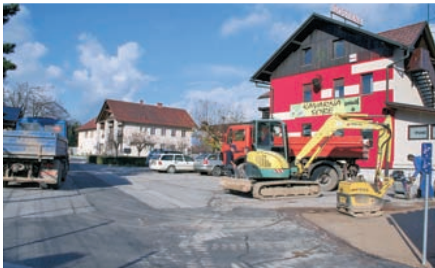
V Naklem so obnovili napeljave in cestišče v treh ulicah, novembra tudi na Kranjski cesti.
