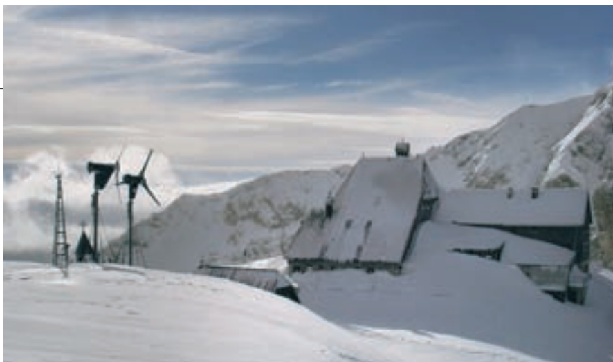
Na Kredarici sta trenutno dve vetrnici, vsaka daje v idealnih razmerah do 6 kW energije. Foto: Zvone Sinkovič
