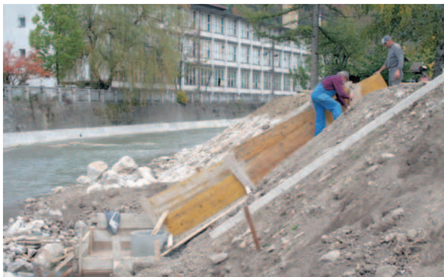
Nasproti tovarne Peko so postavili novo vodomerno postajo in oporni zid.
