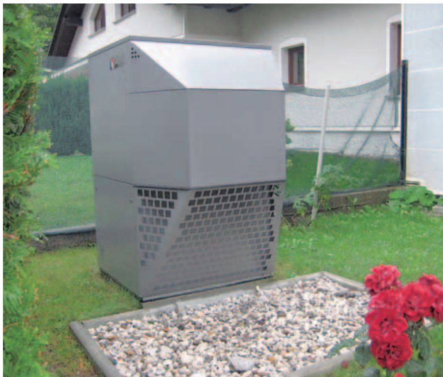
Toplotna črpalka zrak-zrak je ena najcenejših možnosti ogrevanja s pomočjo sončne energije. / Foto: Boštjan Bogataj
