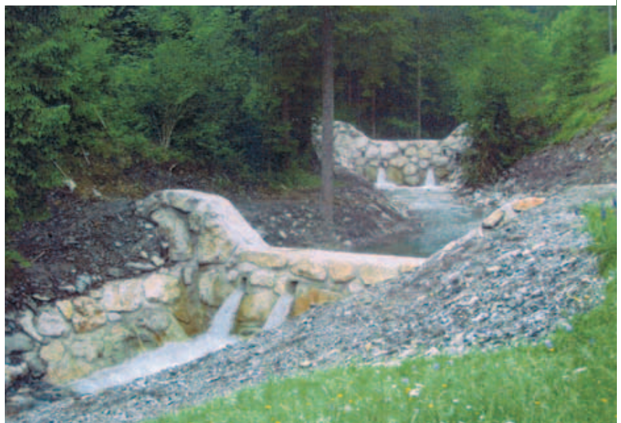
Na hudournikih v občini Železniki so gradili zaplavne pregrade in vodne pragove.
