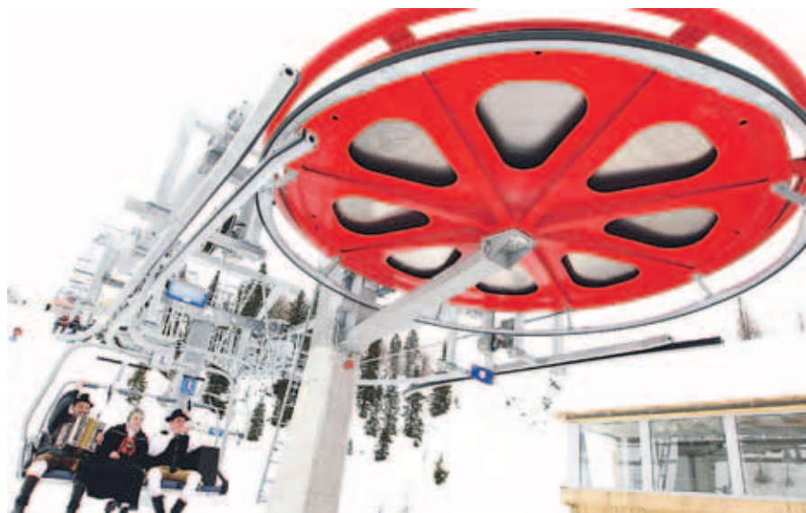
Na Voglu so zgradili novo štirisedežnico
