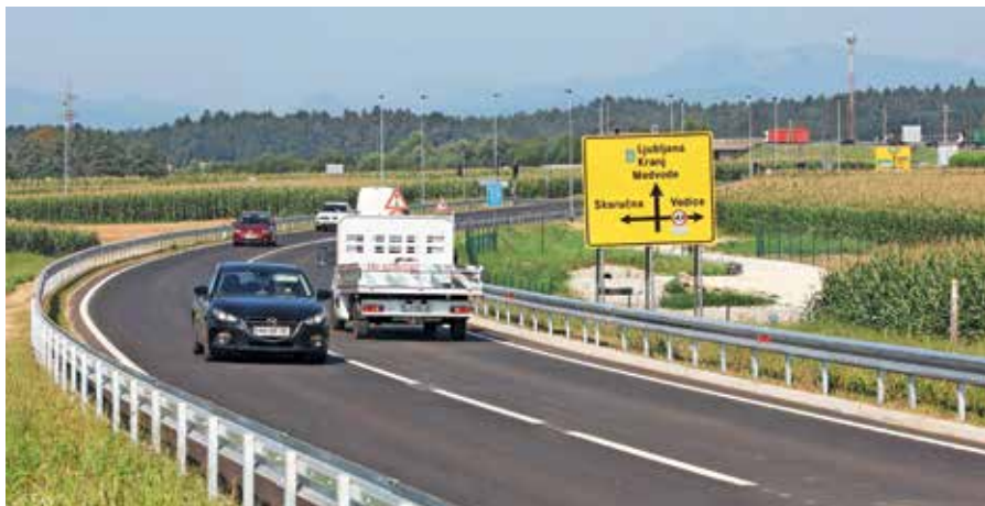
Nova obvozna cesta mimo naselja Vodice je preusmerila prometne tokove. / FOTO: GORAŽD KAVČIČ
