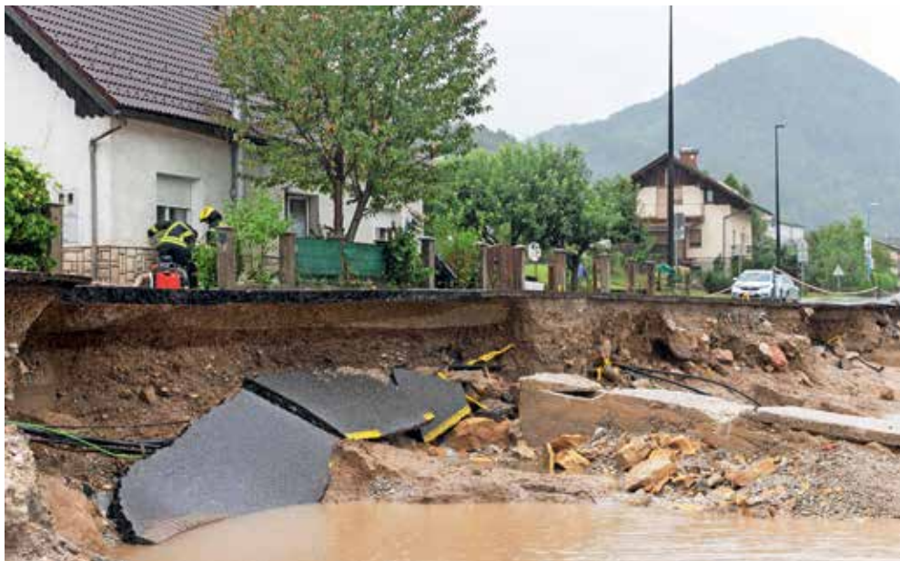
ŠKODA JE velika tudi na občinski infrastrukturi. Fotografija je iz Goričan, kjer je na območju kopališča odneslo del cestišča. / FOTO: PETER KOŠENINA
