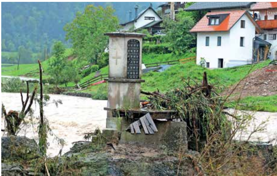
V PUŠTALU je reka porušila Hudičevo brv. / FOTO: TINA DOKL
