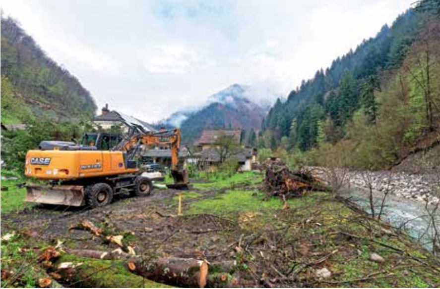
ZAČETEK GRADNJE obvoznice pri nogometnem igrišču v Železnikih
