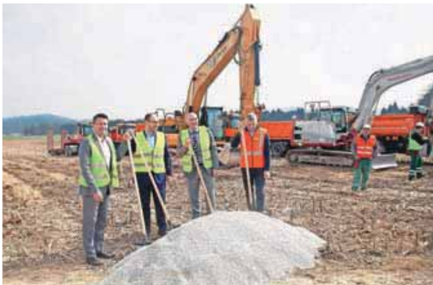
ZAČETEK GRADNJE obvoznice v Vodica
