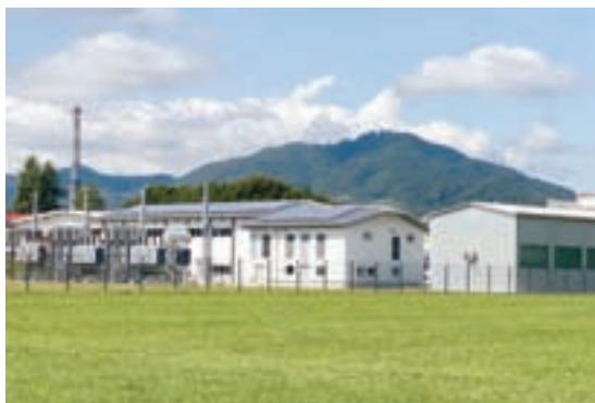
RTP Labore je največji energetski objekt, na katerega so priključeni industrijski odjemalci na Laborah.
