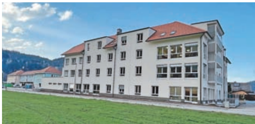
Gradnja doma za starejše se bliža koncu.
