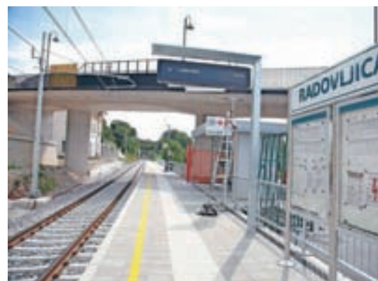
Novo železniško postajališče v Radovljici
