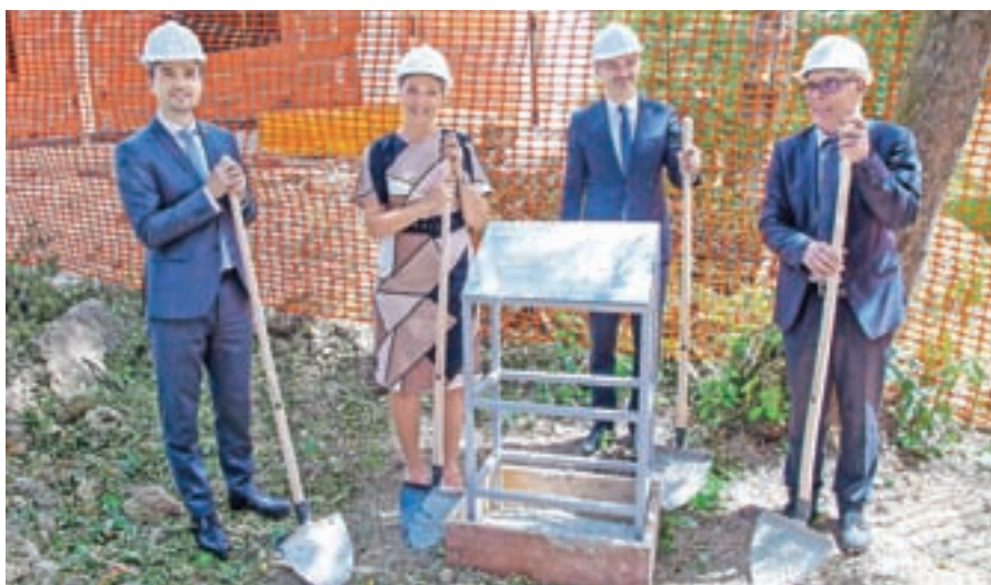
Začetek gradnje doma starejših v Komendi
