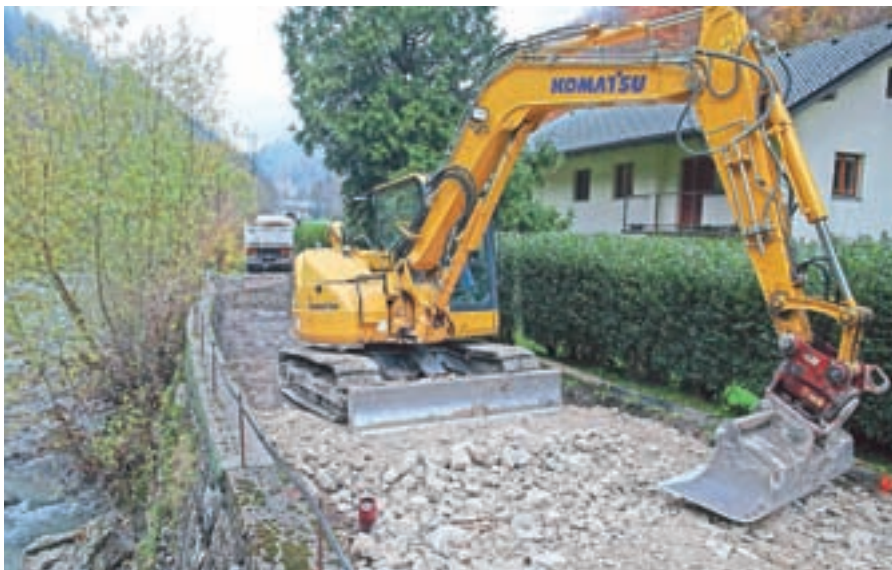
Gradnja nove kolesarske steze na Jesenovcu
