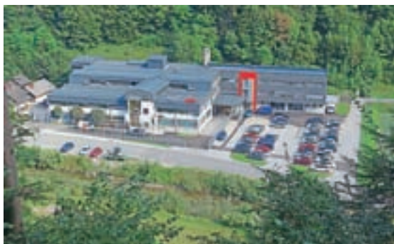
Pri objektu Na plavžu so končali gradnjo prizidka. Foto: Igor Mohorič Bonča
