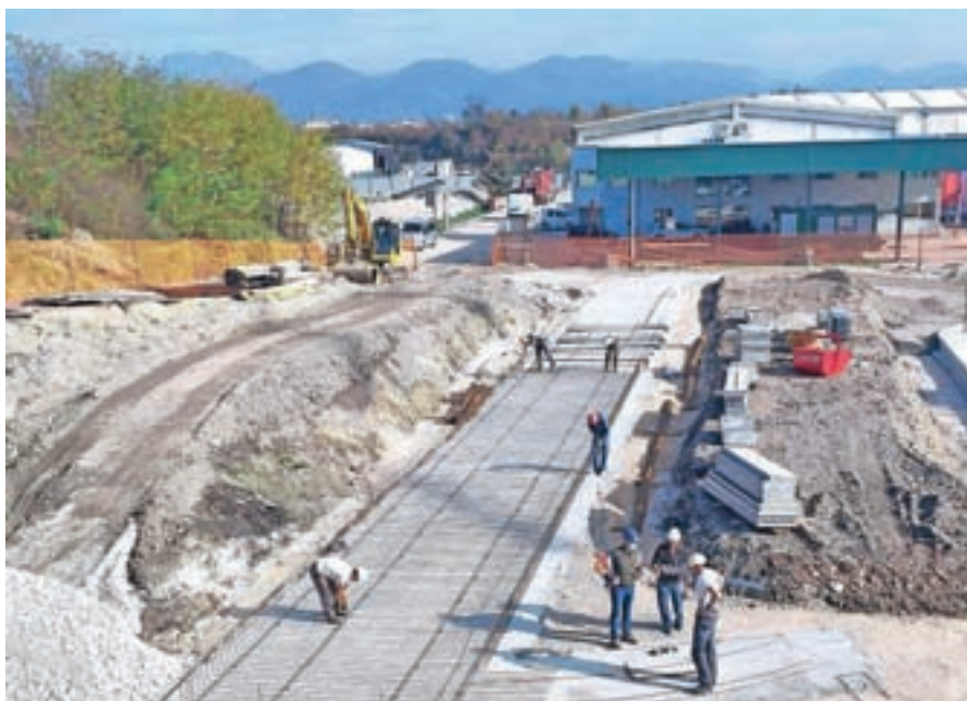
Gradnja zbirnega centra za komunalne odpadke
