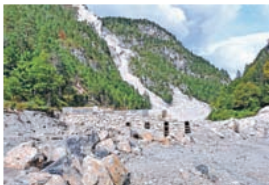
Gradnja zaplavne pregrade na vodotoku Belca
