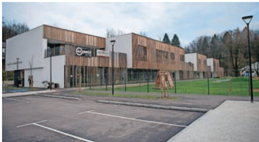
Po letu dni gradnje so v Škofji Loki odprli novi Vrtec Kamnitnik.
