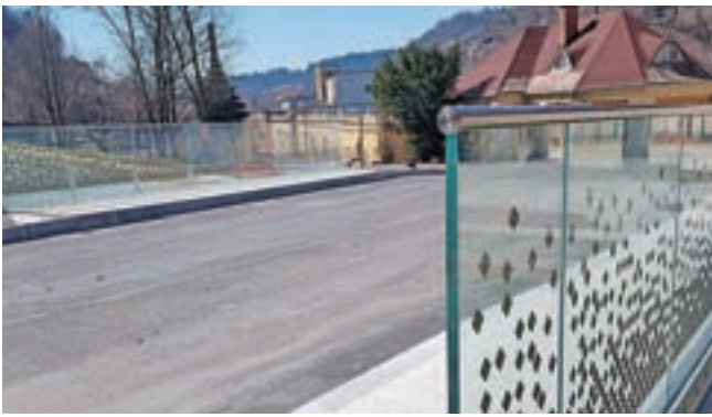
Severni most, ki predstavlja vhod v BPT, je po obnovi varen, nosilen in tudi z gradbenimi detajli povezuje preteklost s prihodnostjo. / Foto: arhiv Občine Tržič
