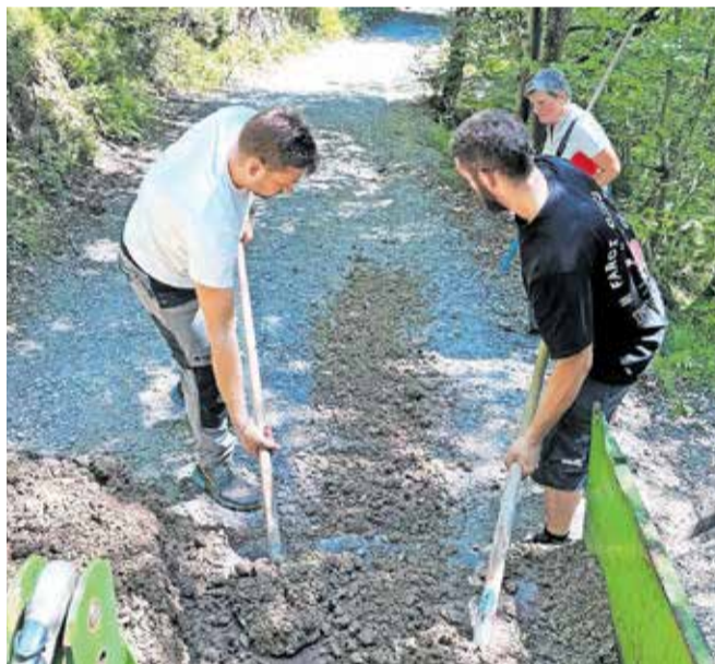
Čistili so jaške, kanale in struge vodotokov ter nasuli in utrdili poti. / FOTO: KS JOŠT/MARKO BAJT
