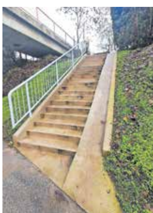
Stopnice z Delavskega mostu v KS Čirče
