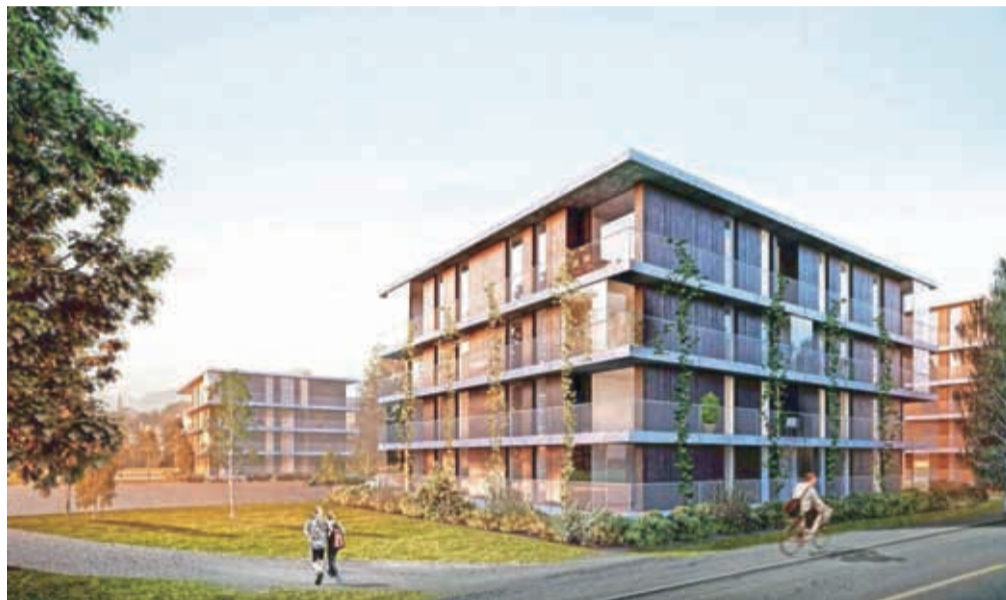
Soseska Ob Savi – MOK bo zagotovila komunalno in prometno infrastrukturo. / Foto: MOK
