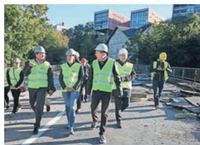
V sredo so si gradbišče ogledali tudi kranjski župan Boštjan Trilar, ministrica za infrastrukturo Alenka Bratušek in pristojni z Direkcije RS za infrastrukturo. / FOTO: GORAZD KAVČIČ
