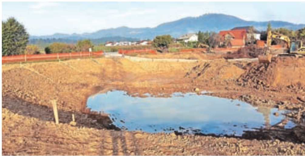
Ureditev zadrževalno-ponikovalnega polja Bantale bo pomenila celovito rešitev zalednih in padavinskih voda na območju Stražišča.
