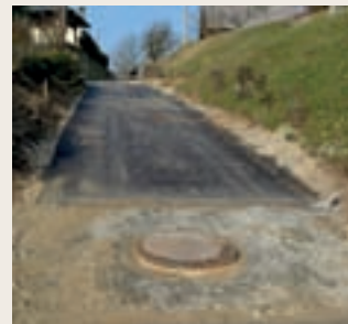
Priprave na asfaltiranje v Predosljah
