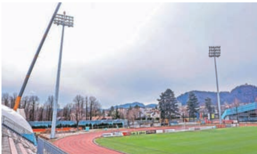
Prejšnji teden so na kranjskem stadionu postavili štiri reflektorje. / Foto: Tina Dokl
