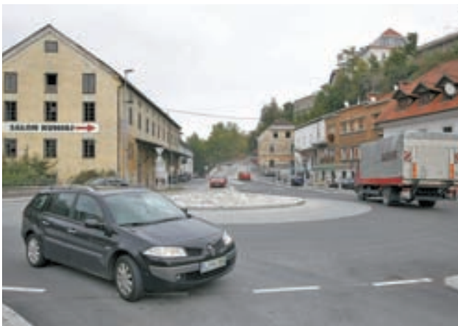
Ob izgradnji krožišča na dnu Jelenovega klanca so obenem obnovili vse instalacije pod krožiščem, gradnjo, ki je trajala devet mesecev, pa je delno financirala Evropska unija.
