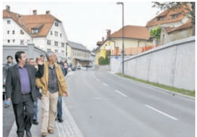
Po odprtju ceste in krožišča si je župan Damijan Perne skupaj z gosti ogledal novosti, med katerimi je tudi 200 metrov opornega zidu pod Sejmiščem s stopniščem na Sejmišče.
