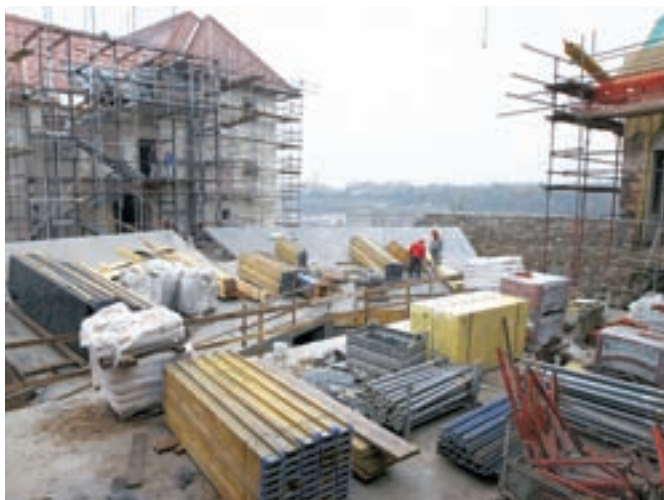
Na gradu Khislstein prenova poteka po načrtih, izvajajo se krovsko-kleparska dela, vidi pa se že podoba odra in tribun.
