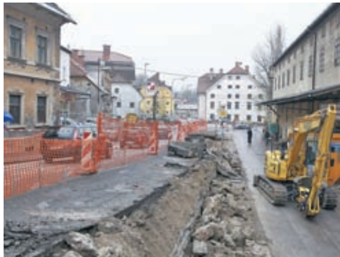
Trenutno pod Jelenovim klancem potekajo pripravljala dela za gradnjo novega krožišča, ki naj bi ga zgradili v letu dni.
