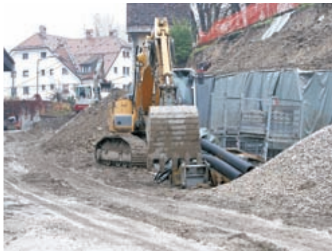
Dela na Savski cesti so se zavlekla, predvidoma pa naj bi jo asfaltirali in odprli za promet konec decembra.
