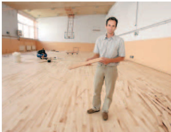
V telovadnici osnovne šole Matije Čopa so zamenjali tlake in strop.
