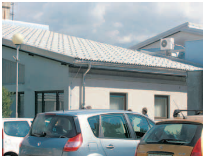
V Predosljah so zdaj v celoti obnovili streho.
