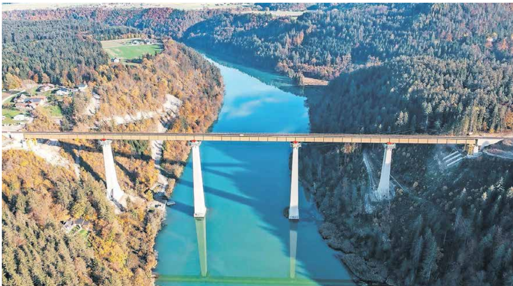
Visokohitrostna železniška proga iz Celovca čez Dravo ter skozi predor Golica v Gradec / Foto: ÖBB/ Evmedia
