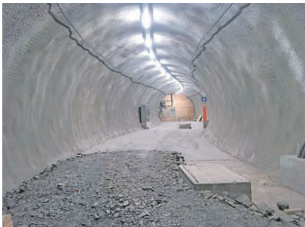
Prečni prehod, ki v času gradnje služi kot zasilni izhod, na avstrijski strani / Foto: arhiv Asfinaga
