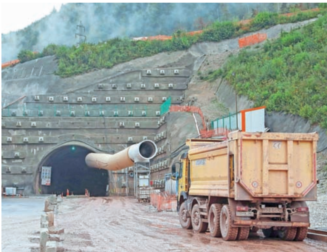
Gradnja druge cevi na Hrušici / Foto: Gorazd Kavčič
