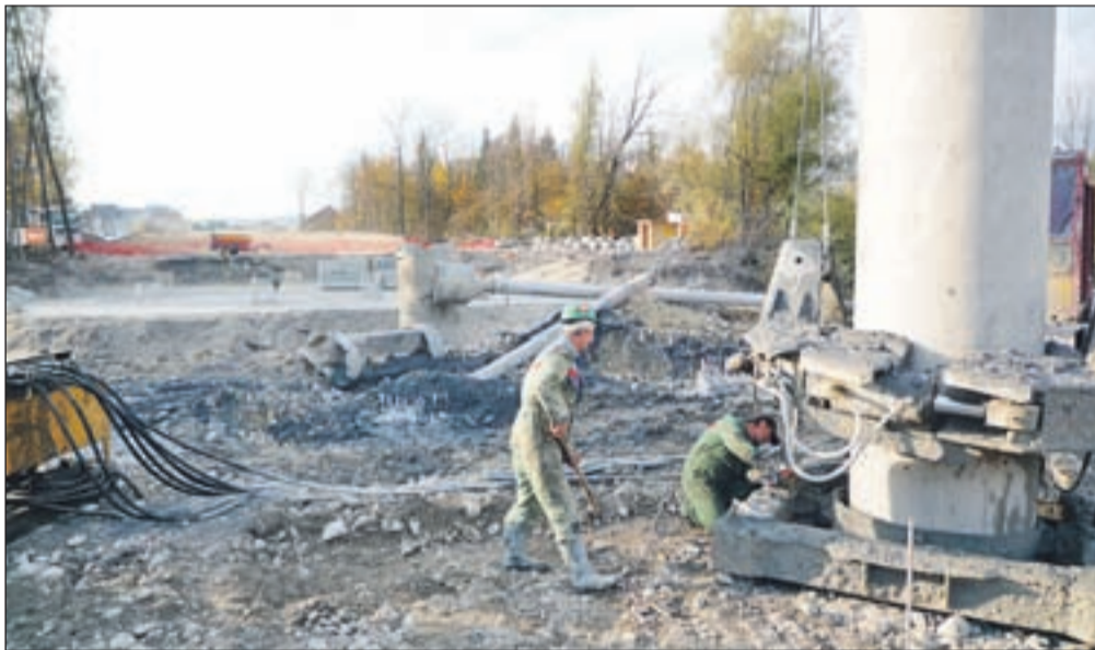
Gradnja Povezovalne ceste treh mostov bo zaključena septembra 2010.
