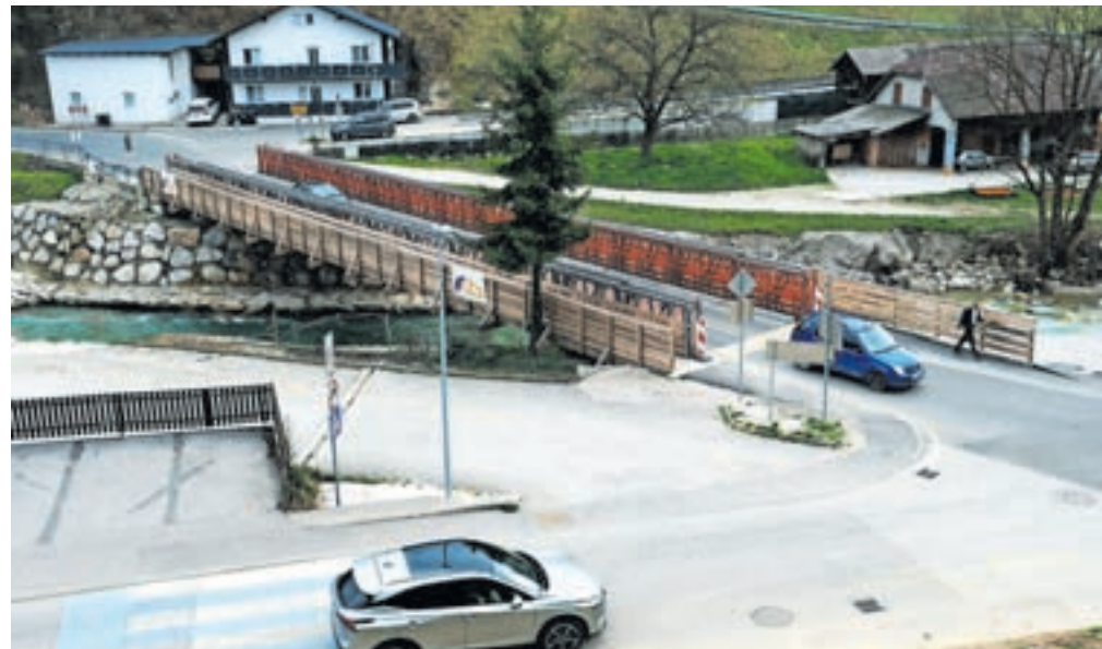
Montažni most čez Kamniško Bistrico v Zgornjih Stranjah bo nadomestil sodobni dvopasovni most. / FOTO: MAŠA LIKOSAR
