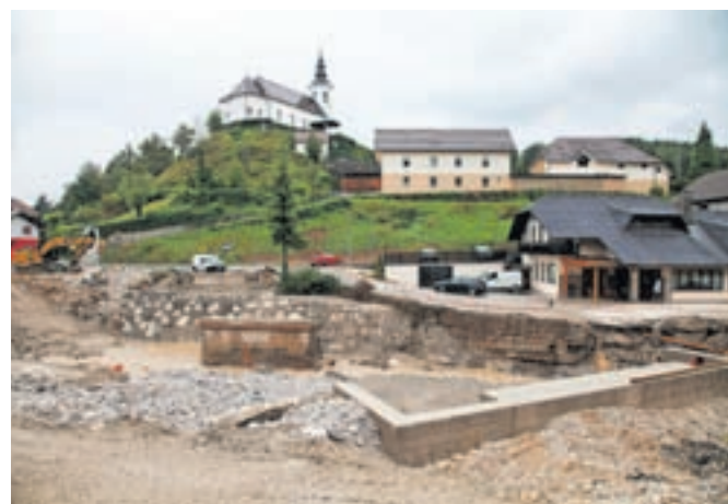
Uničen most v Stranjah so porušili, zdaj čakajo na montažnega. / FOTO: ALEŠ SENOŽETNIK
