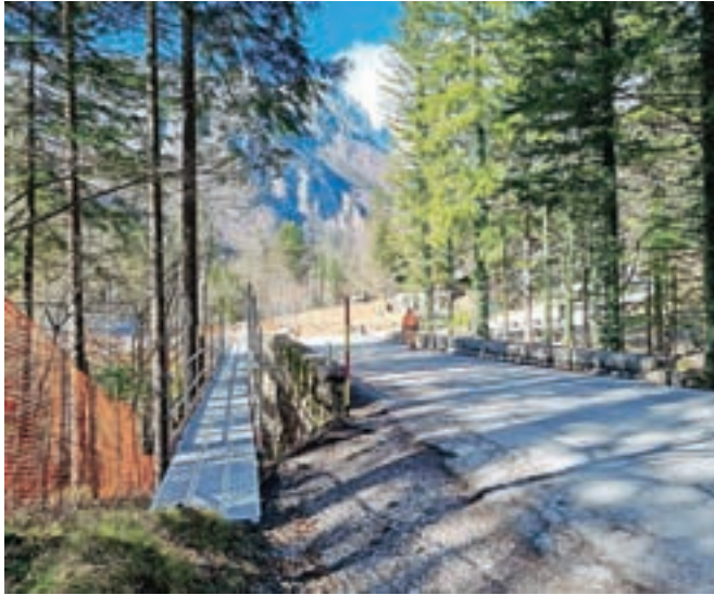
Kamnit most pri izviru Kamniške Bistrice so začeli obnavljati. / FOTO: JASNA PALADIN
