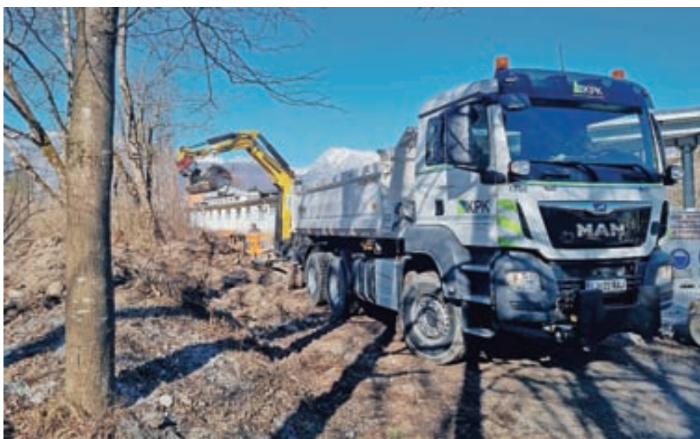
Gradnja kolesarske povezave od Kamnika do Godiča že poteka. / FOTO: JASNA PALADIN
