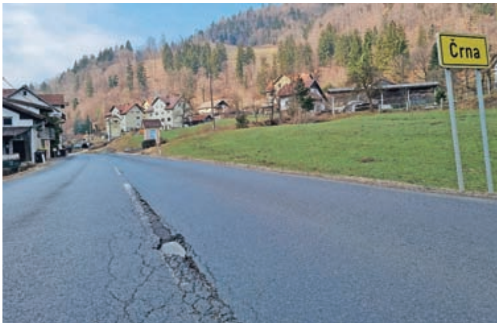
V Črni bodo še do poletja dobili nov asfalt – pa tudi kanalizacijo. / FOTO: JASNA PALADIN
