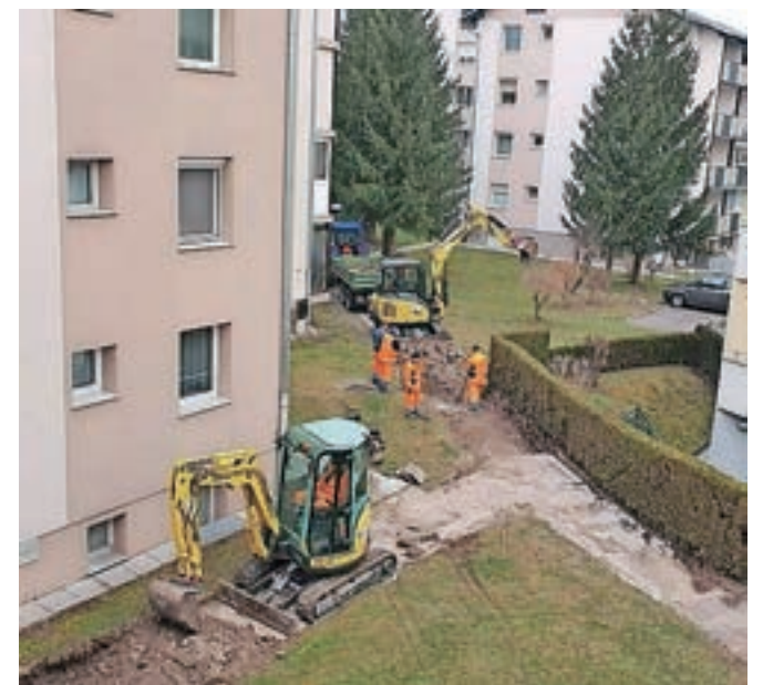
Pot bo po obnovi asfaltirana.
