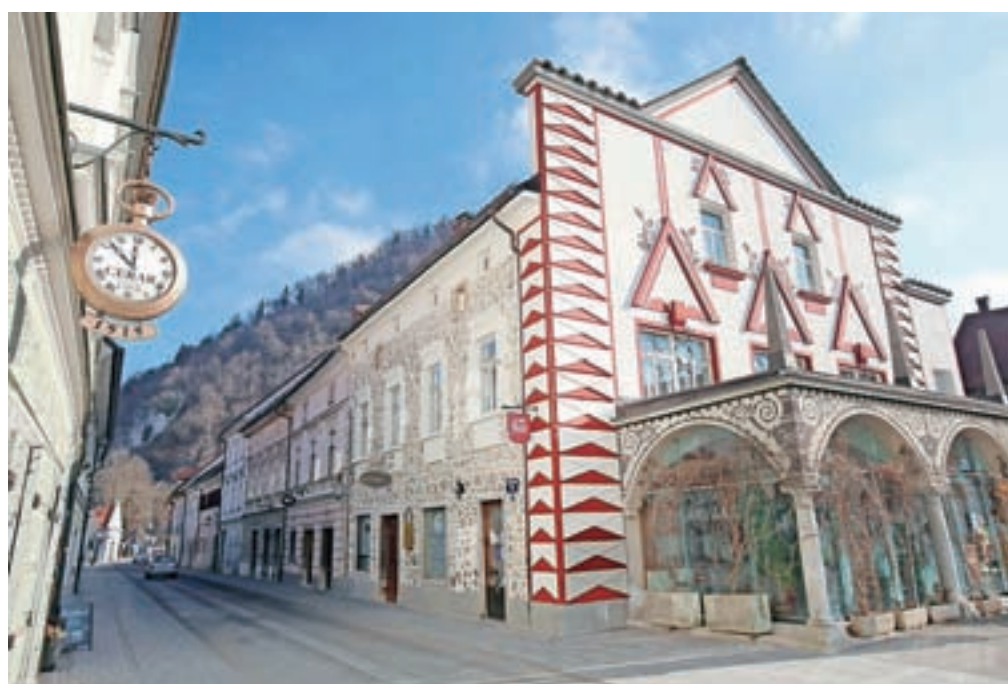
Plečnikova stvaritev, ki obiskovalce Kamnika najprej pritegne, je stavba z imenitnimi fasadama, ki so ju lastniki ob podpori občine prenovili ob koncu lanskega leta. / FOTO: GORAZD KAVČIČ
