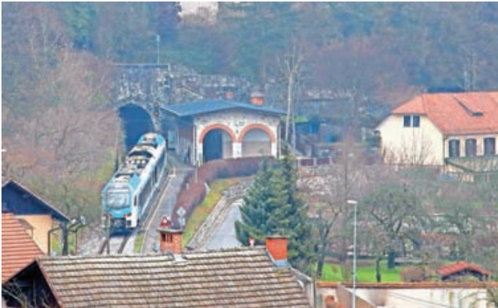
Na kamniški progi že vozi nov vlak, ki pa za boljši javni prevoz ni dovolj. Proga je namreč zastarela in prepočasna, zato je nujna njena posodobitev. / FOTO: GORAZD KAVČIČ
