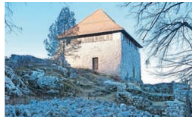
Stražni stolp na Malem gradu ima za zdaj povsem neizkoriščen potencial, a se bo to – predvidoma že letos – spremenilo. / FOTO: JASNA PALADIN
