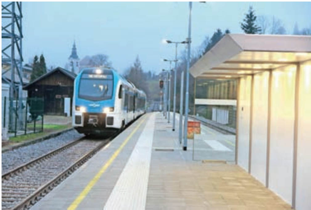
Nov Stadlerjev vlak, s katerim bo potovalni čas po navedbah Slovenskih železnic do deset odstotkov krajši, na prenovljeni železniški postaji Kamnik Graben / FOTO: JASNA PALADIN
