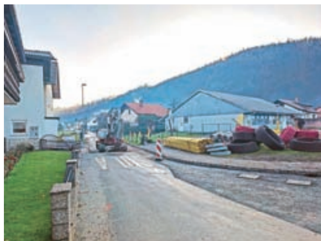
Hkrati poteka tudi gradnja optičnega omrežja. / FOTO: JASNA PALADIN
