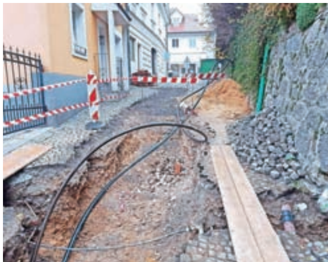
Sadnikarjeva ulica dobiva novo komunalno infrastrukturo in plinovod. / FOTO: OBČINA KAMNIK
