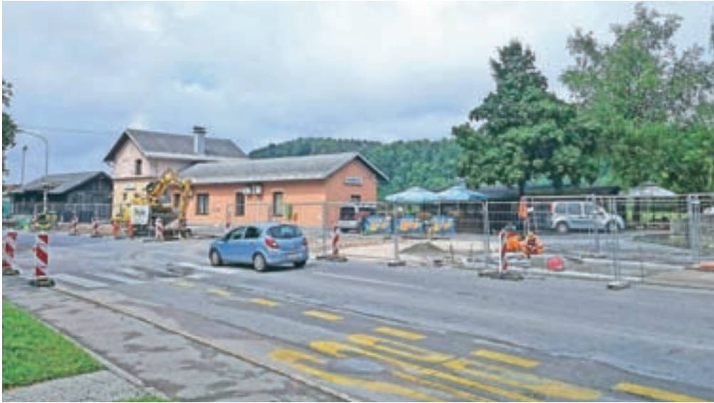
Ob kamniški železniški postaji poteka ureditev križišča sklenjene kolesarske povezave do Glasbene šole Kamnik. / FOTO: JASNA PALADIN
