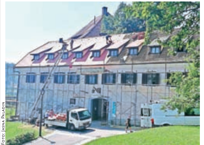
Obnova strehe na vhodnem objektu gradu Zaprice
