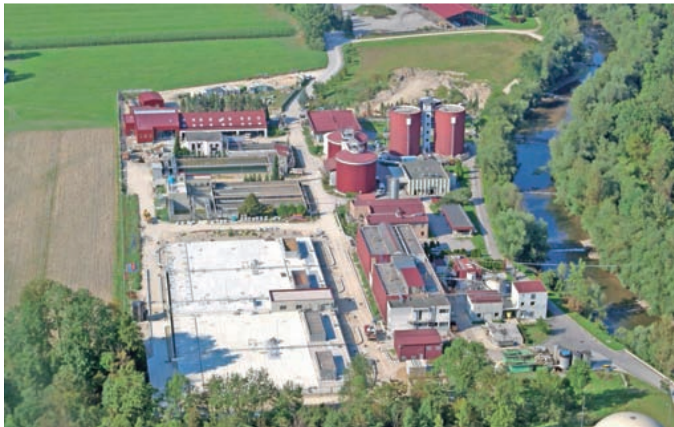
Nadgrajena centralna čistilna naprava Domžale - Kamnik je zdaj ena najsodobnejših pri nas. / FOTO: BLAŽ OMAN
