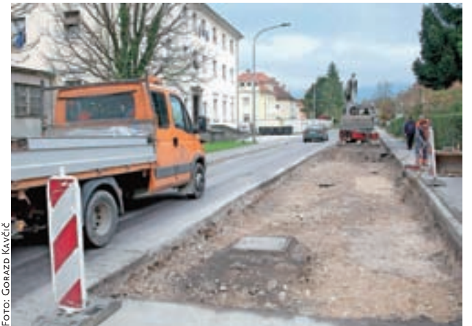
Obnova Cankarjeve ceste bo potekala v osmih fazah.
