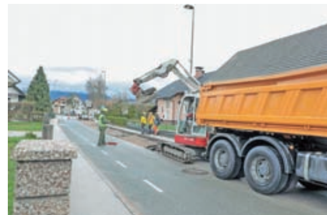
Dela v Srednji vasi so se že začela / FOTO: TINA DOKL
