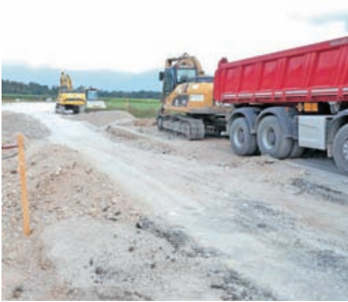
Gradnja na Kranjski cesti / Foto: Tina Dokl
