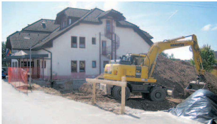
Gradnja prizidka k vrtcu pri OŠ Šenčur
