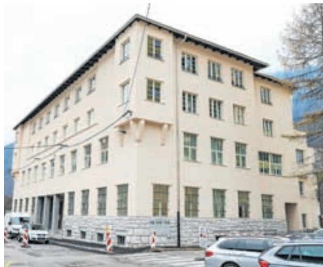
Prenovljena stavba sodišča na Jesenicah / FOTO: NIK BERTONCELJ
