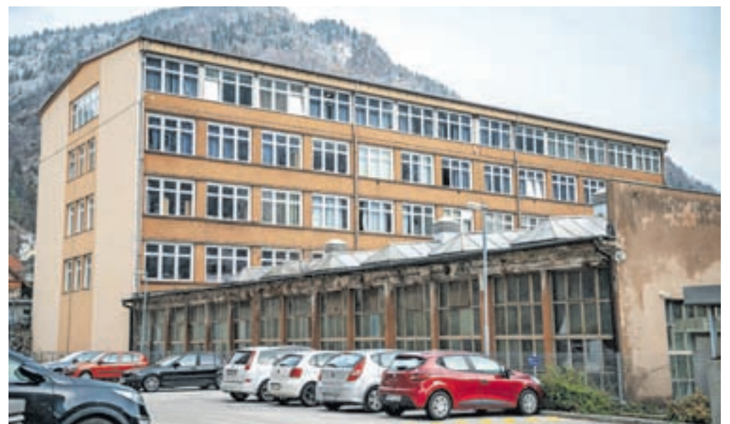
Celovita prenova Srednje šole Jesenice naj bi se začela spomladi 2024 in se zaključila konec aprila 2026. / FOTO: NIK BERTONCELJ
